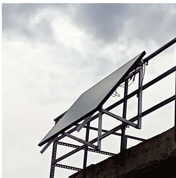
Immagine di installazione tipo su ringhiera
